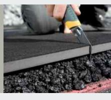
vor, dass die Verlegefläche aus Altschotter besteht. In diesem Fall hat es sich bewährt, die Matten beidseitig mit einer Lastverteilerschicht zu versehen.
