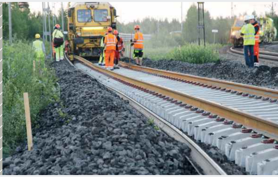
Einbau beschotterter Schwellen auf der Strecke Malmabanan
