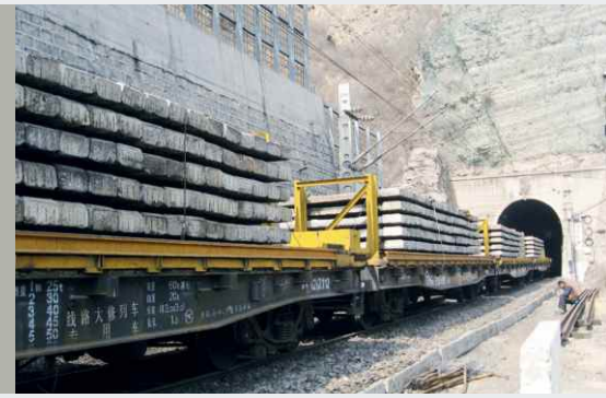
Besohlte Schwellen für die Fengsha Linie
