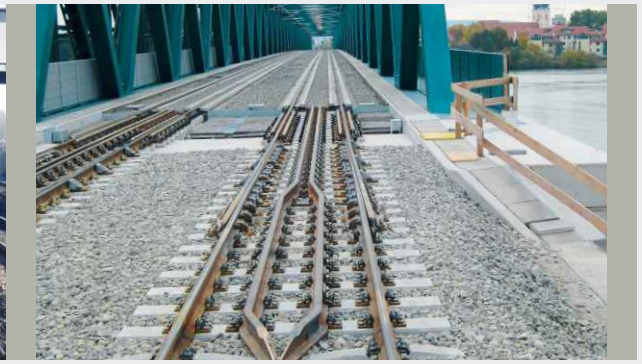
Übergangsbereich auf eine Stahlbrücke
