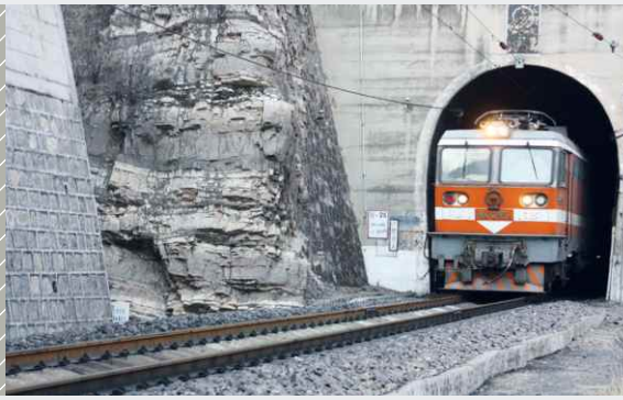
Tunnel auf der Fengsha Kohlelinie in China
