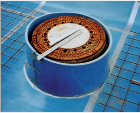
Isolation eines Masse-Feder-Systems gegenüber einer Kanalleitung
